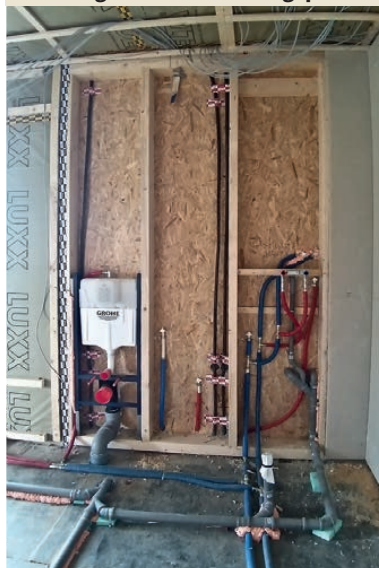
9. A belső burkolás következik. Még látható a modern gépészet...
