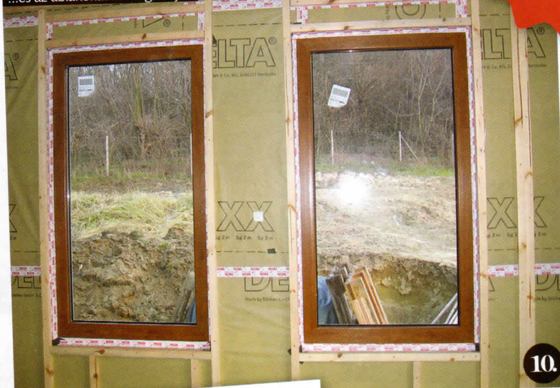
Dagad a fólia, befújják a cellulóz-szigetelést
