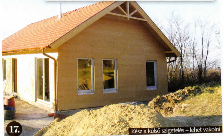
Farosttábla-hőszigetelés: ehhez fűrész kell
