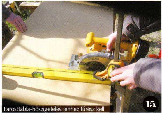
Farosttábla-hőszigetelés: ehhez fűrész kell
