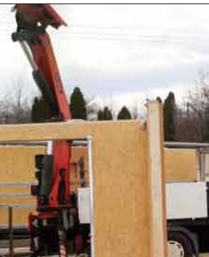
3 Daruval helyükre kerülnek a külső falpanelek.
