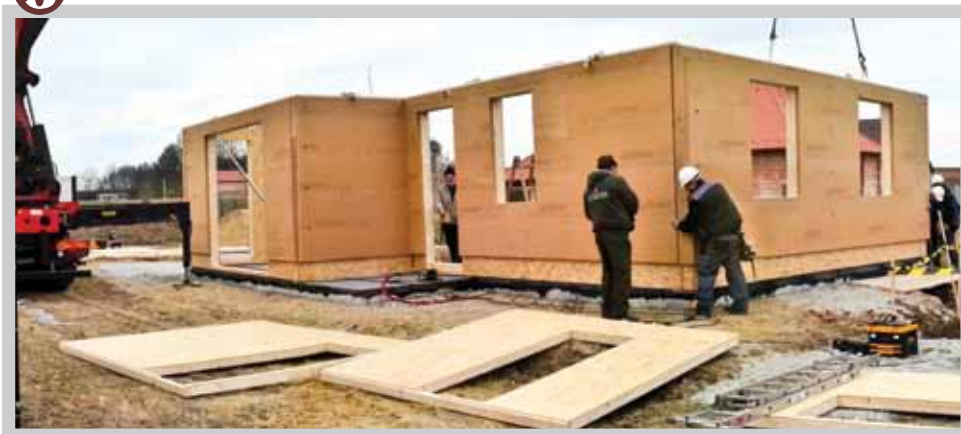
3 Daruval helyükre kerülnek a külső falpanelek.
