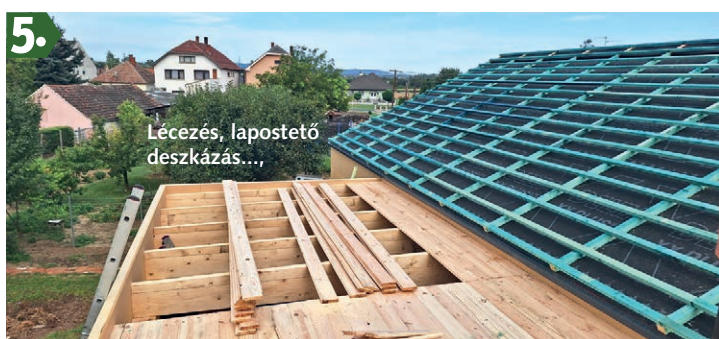
...tetőszerkezet fóliázása Dörken Delta XX Plus páraáteresztő fóliával
