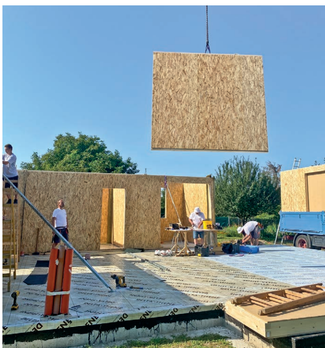
2. Földszinti falak daruzása és összeszerelése.
